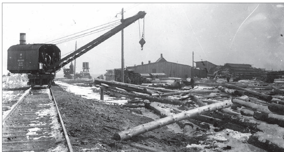
» Budowa Portu Gdynia
